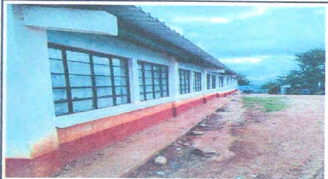
Foto 2: Balcones de ventanas
