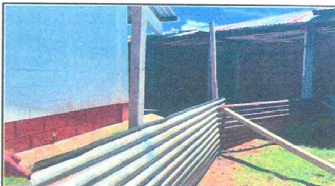
Foto 4: Reparación de muro perimetral de block con tubo y malla galvanizada
