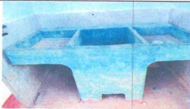
Foto 1: Sustrucción de Pila plástica de dos lavaderos
