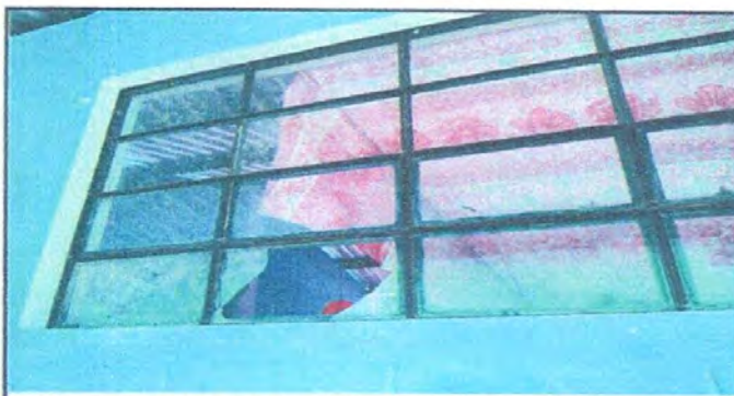
Foto 6: Sustrucción de Vidrios
