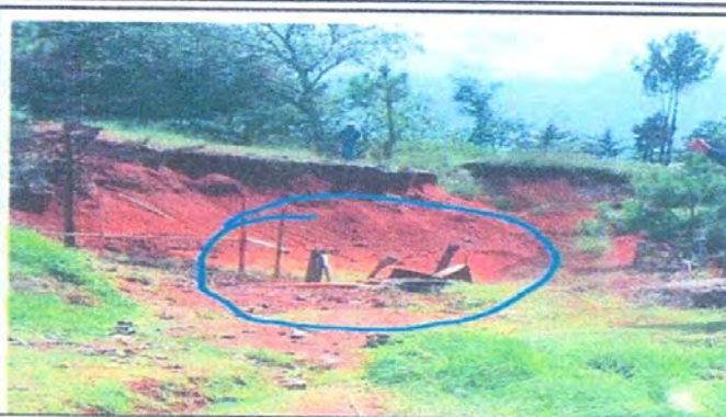
Foto 2: Mantenimiento y reparación de fosa séptica
