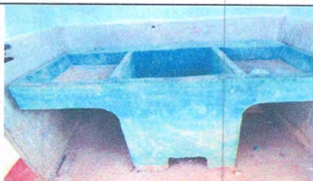
Foto 3: Sustrucción de grifo
